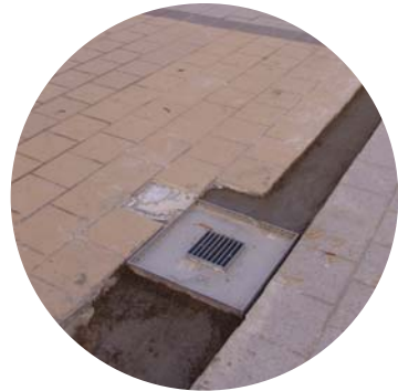
■ 외부 Box 설치 형태
