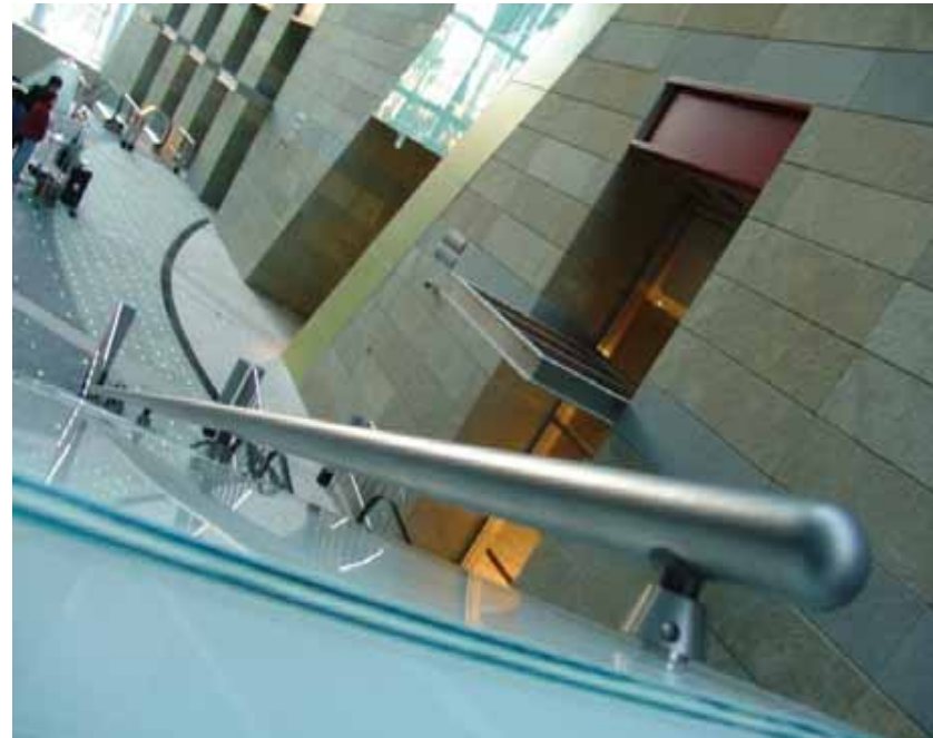
▶ [스타시티 연결통로] 핸드레일 부착형 파이프 스피커
