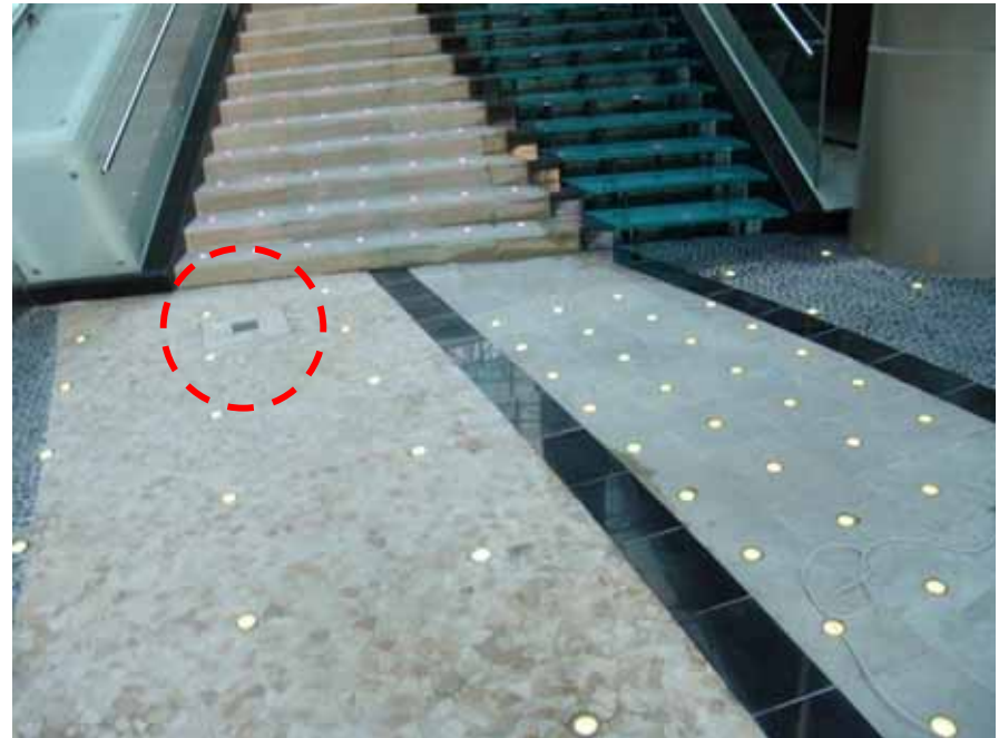
▶ [스타시티 연결통로] 바닥에 배입하여 설치 한 그라운드 스피커
