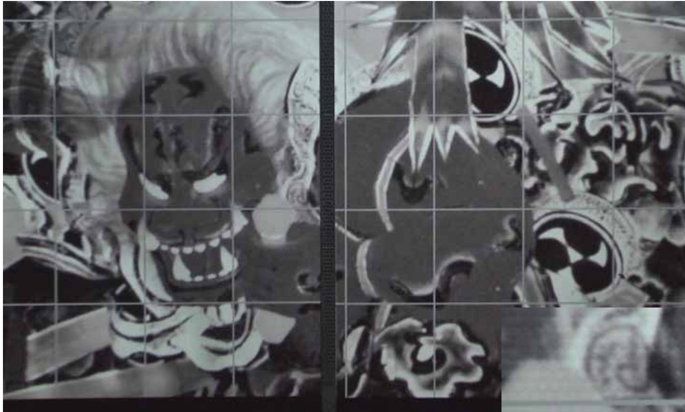
▶ [일본 아오모리 브타 문화회관] 벽면 틈에 슬림 평판 스피커 설치사례
