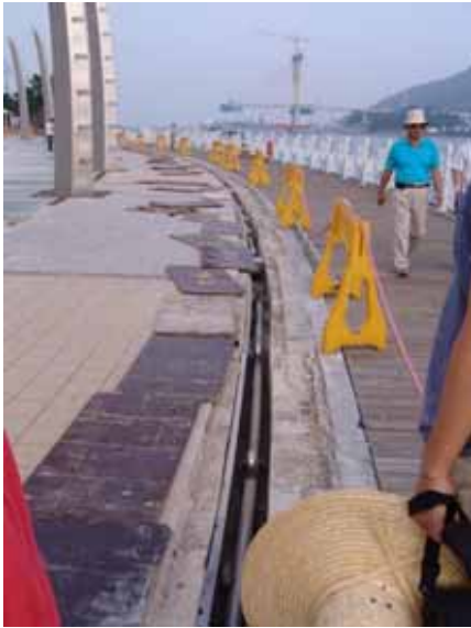
▶ [여수 종포 해양공원]바닥 드레인 안에 파이프 스피커를 설치
